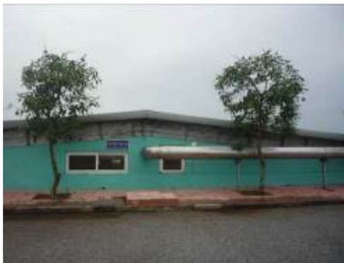
Hồ xử lý hiếu khí có mái che và hệ thống hút mùi để không chế phát tán mùi hôi và thải vào môi trường không khí xung quanh khu vực nhà máy XLNT Đức Ninh
