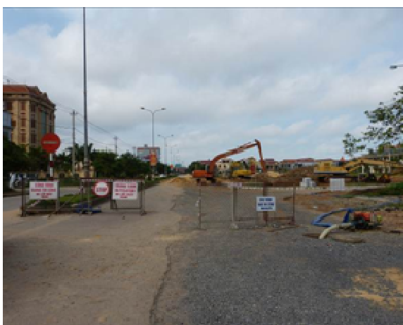
Khu vực thi công tuyến đường có biển báo, hàng rào chắn
