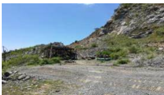
Lán trại tạm bợ, không rào chắn
