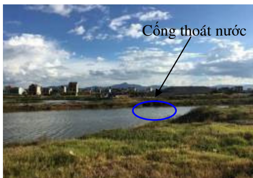
Cống thoát nước phía chùa Đại Giác
