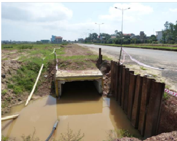
Dùng Cừ larsen chống sạt lở trong quá trình thi công cống
