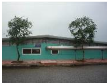
Bể điều khí có mái che và hút mùi
