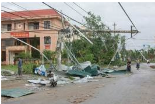
Cột điện bị gãy
