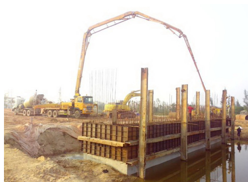
Thi công mô trụ cầu
