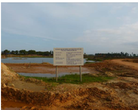
Biển báo khu vực thi công nhà máy xử lý nước thải Đức Ninh
