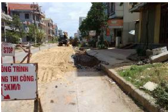
Biển báo và rào chắn tại khu vực thi công các tuyến công tại khu vực đông dân cư
