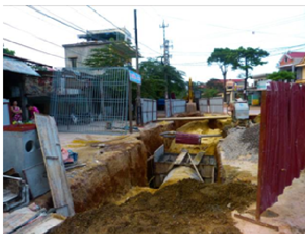
Hàng rào chắn khi đào đường đặt cống
