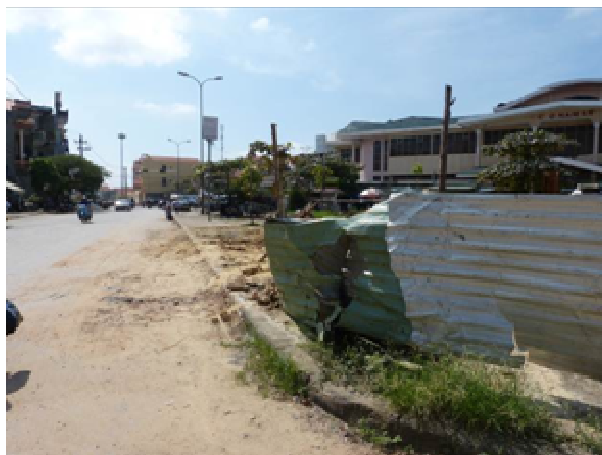
Rào chắn quây công trường thi công hố trạm bơm
