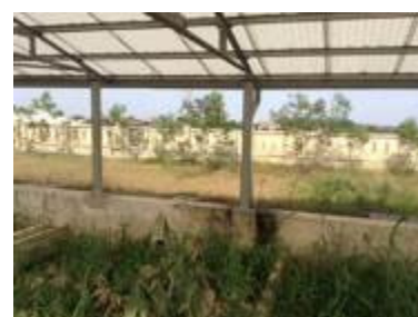
Khu vực chứa bùn thải có mái che, tường bao và trồng cỏ để hạn chế ô nhiễm
