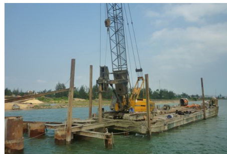
Thi công trụ cầu
