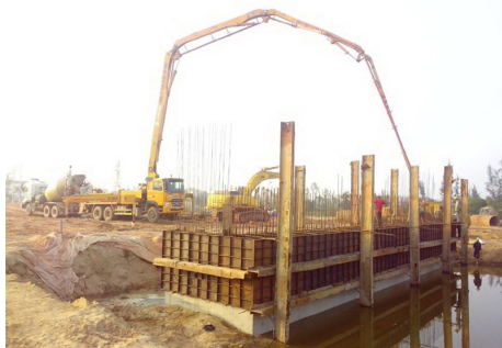
Thi công mố trụ cầu
