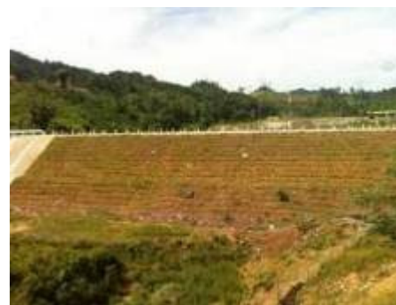
Hình 1.12: Mái taluy trồng cỏ
