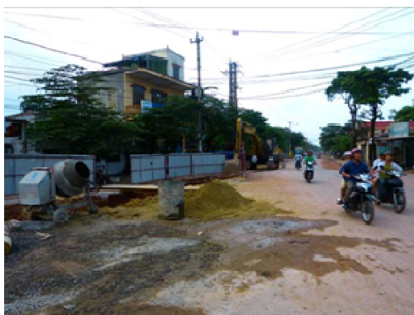
Tường bao ngăn cách khu vực thi công với nhà dân và người tham gia giao thông
